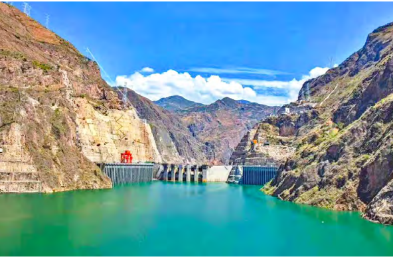
中国建材总院低热水泥助力建设世界最薄乌东德水电站大坝
