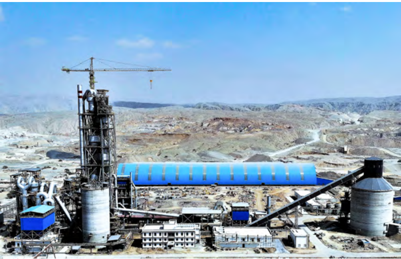
天津水泥院阿联酋JSW项目
