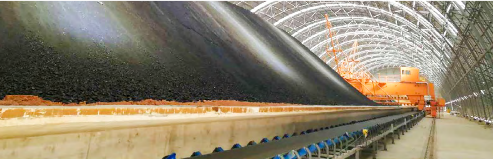
祁连山水泥有限公司清洁生产线
